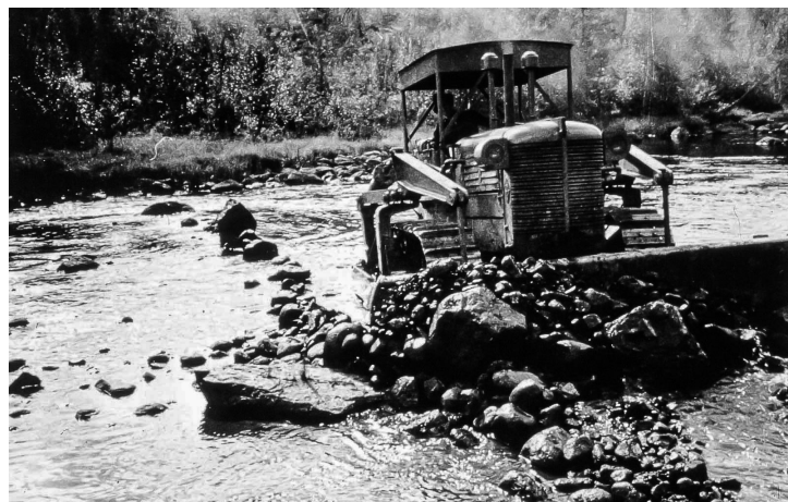
Bortrensning av sten och block från vattendrag med hjälp av bandtraktor för att lättare kunna flotta timmer.
